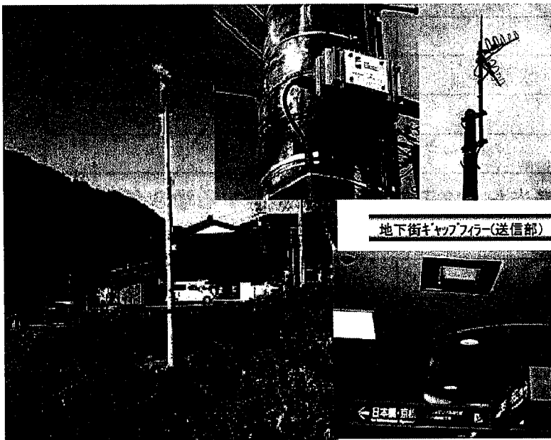
山間部などの条件不利地域向けギャップファイラー(10mW送信)
